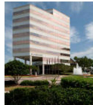
500 N. Westshore Blvd.
